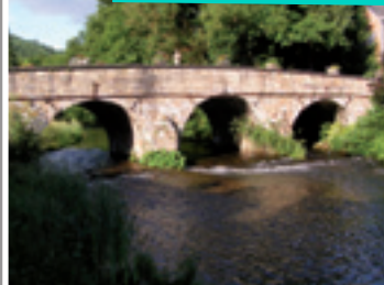
LE PONT D'OUTRELEPONT : mentionné au 13ème siècle, le pont en pierres date du 17ème
