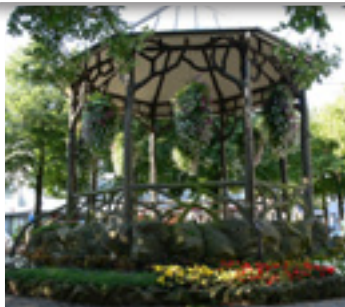
LES TROIS KISQUES : construits au début du 20ème siècle, sur 3 places, comme kiosque à musique
